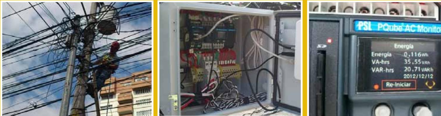
Con la instalación de estos equipos, es posible recibir información de parámetros de calidad de energía, teniendo capacidad para registrar los parámetros de tiempo y duración de interrupciones, variaciones y distorsiones en la calidad de energía de las redes de distribución, entre otros, obteniendo la información vía mail interno y siendo posible la interrogación del equipo en cualquier momento y así obtener datos reales de las condiciones de la red en donde se encuentra instalado el mismo.
